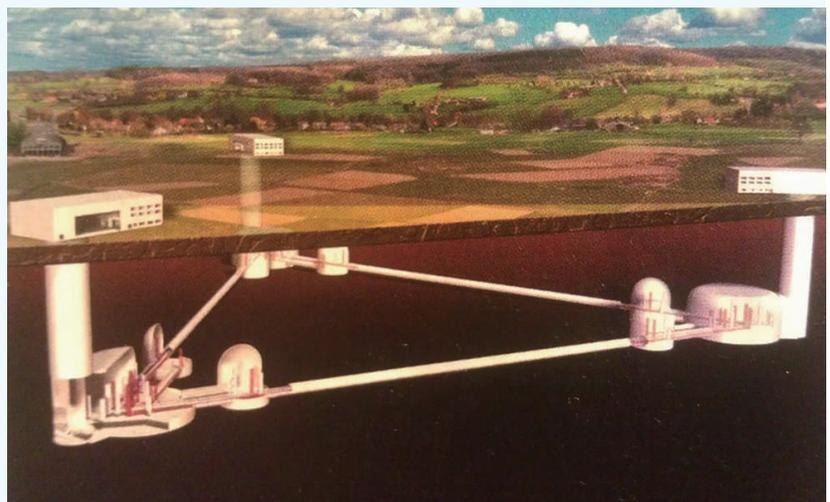
图 6 欧盟设计计划中的爱因斯坦望远镜<sup>[10]</sup>
